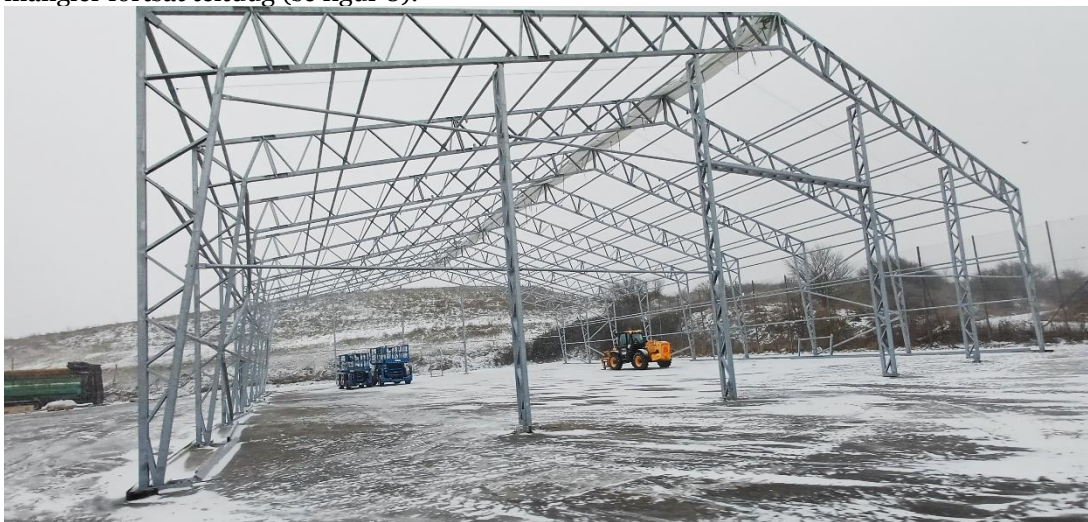
Figur 8 Nye telthal under opbygning
