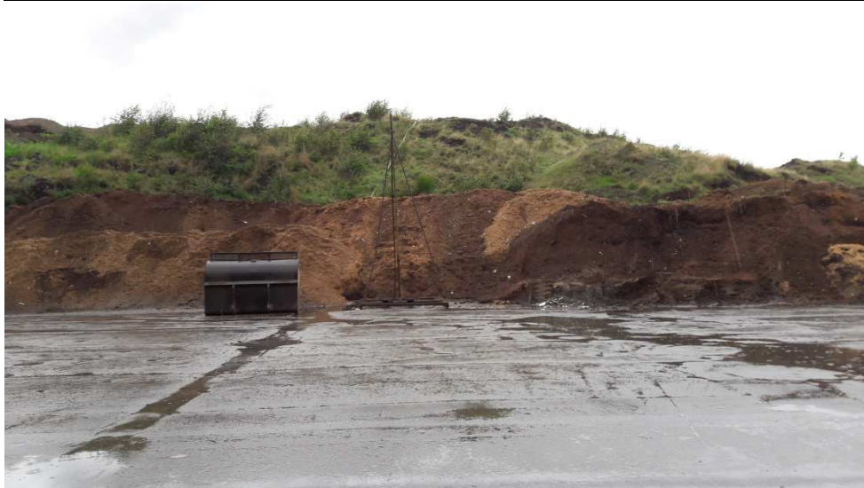
Figur 1 Oplag af støvfraktion til afbrænding i Kraft 5. I forgrunden ses sprinklersystem.
