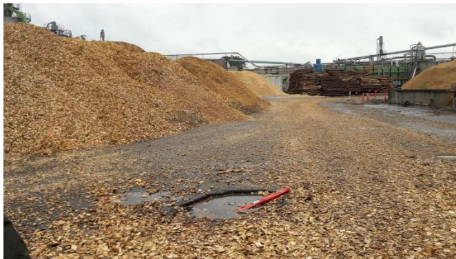
Figur 2 Eksempel på hul i belægning
