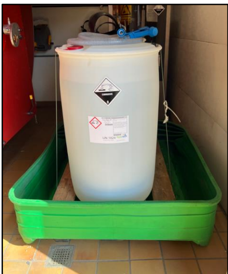
Lud placeret i spildbakke efter tilsyn
