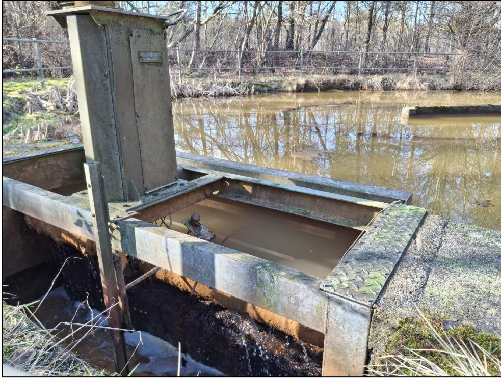
Foto 7: Overløbsbygværk fra ringkanalanlægget.
