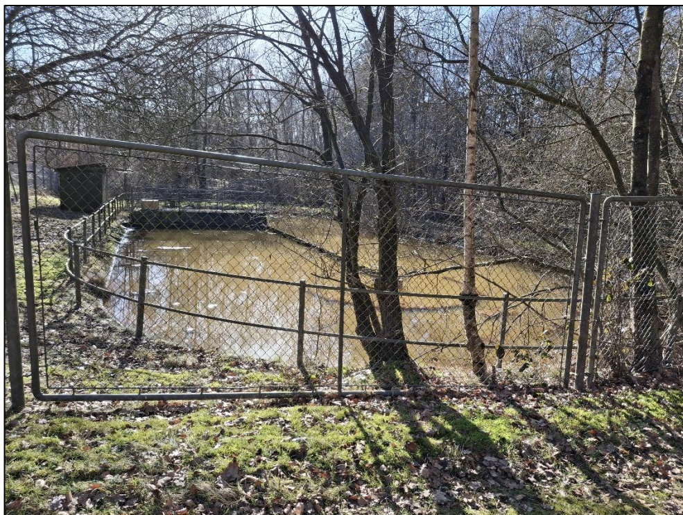
Foto 6: Ringkanalanlæg, hvori perkolat opsamles forud for afledning til Gram Renseanlæg.
