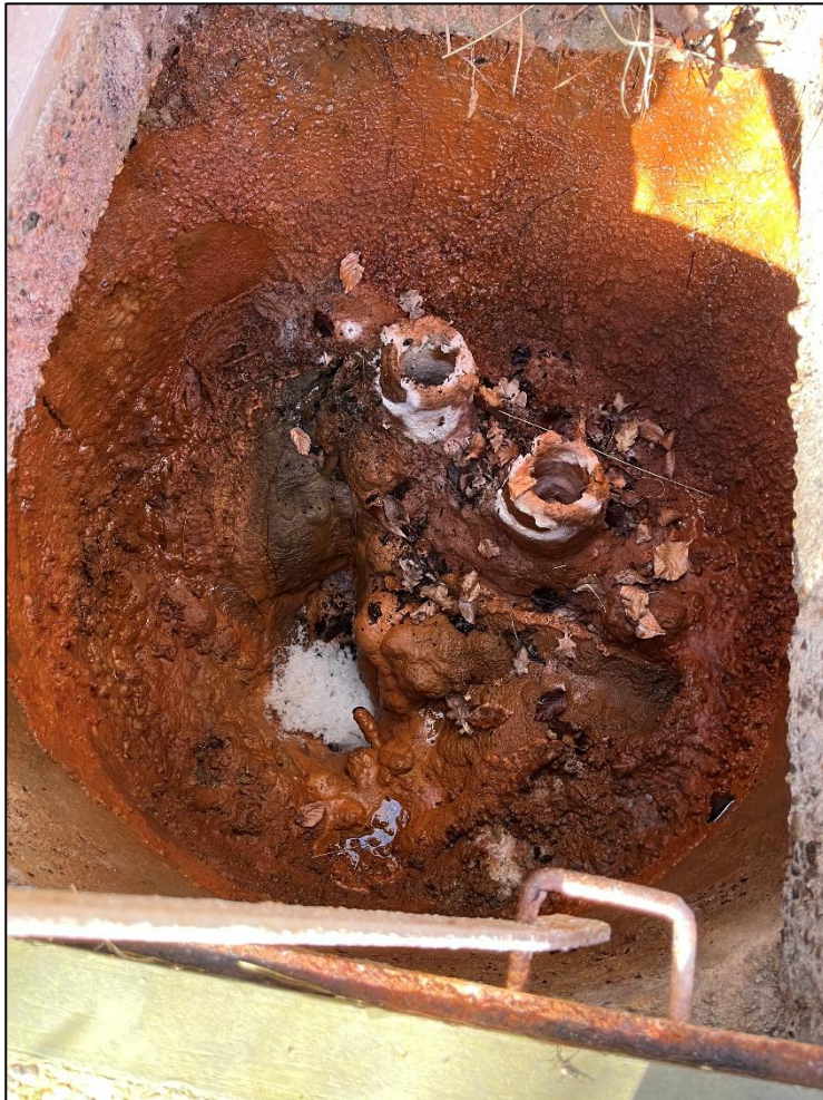
Foto 5: Kig ned i perkolatsamlebrønd.
