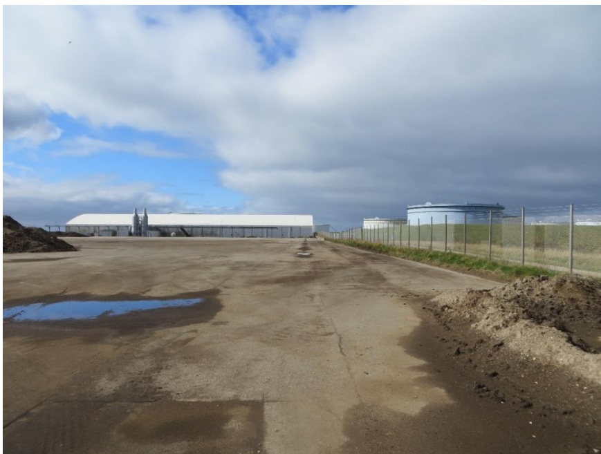
Nye slamplads: Afvandingslaguner er fjernet fra den nye slamplads. Men den forurenede jord, der afgrænsede lagunerne ligger stadig på pladsen, kørt sammen i bunker.
