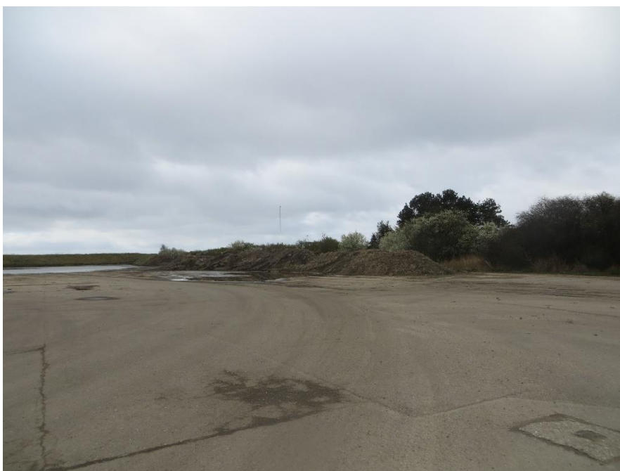
Gamle slamplads: Afvandingslaguner er fjernet fra den gamle slamplads. Men den forurenede jord, der afgrænsede lagunerne ligger stadig på pladsen, kørt sammen i en bunke.
