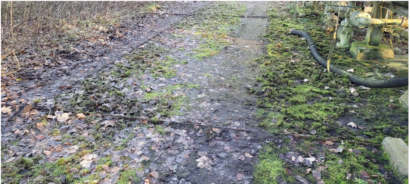
Den befæstede påfyldningsplads med opkant.
