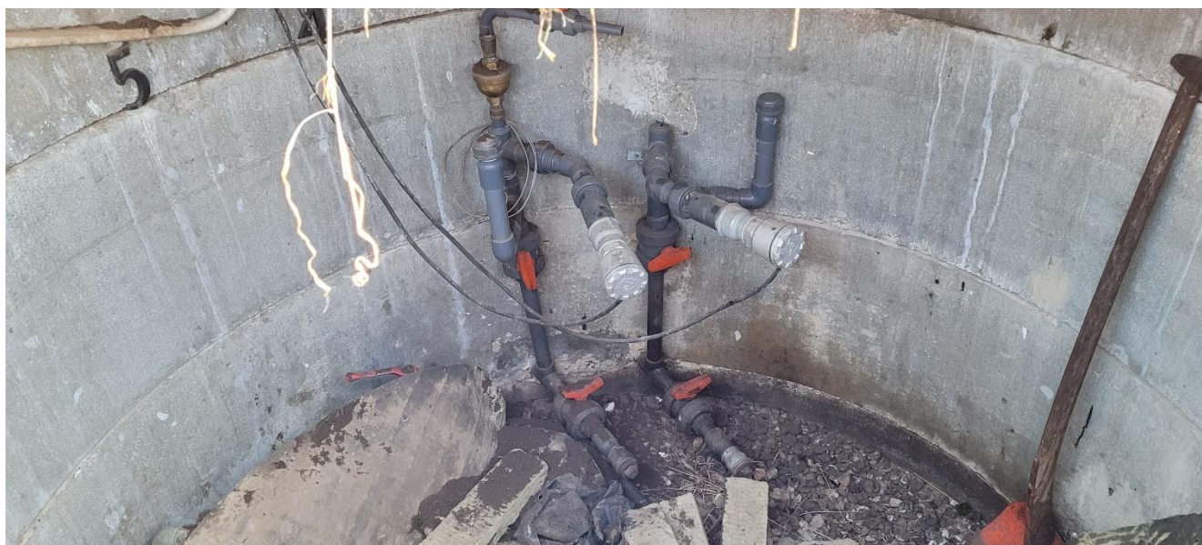
Sladredræn fra hulrum mellem tank og betonkappe med haner fra tank 6 og 7.
