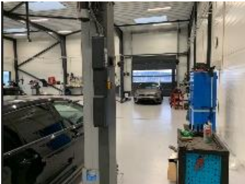
Foto som viser belægning i værkstedet
