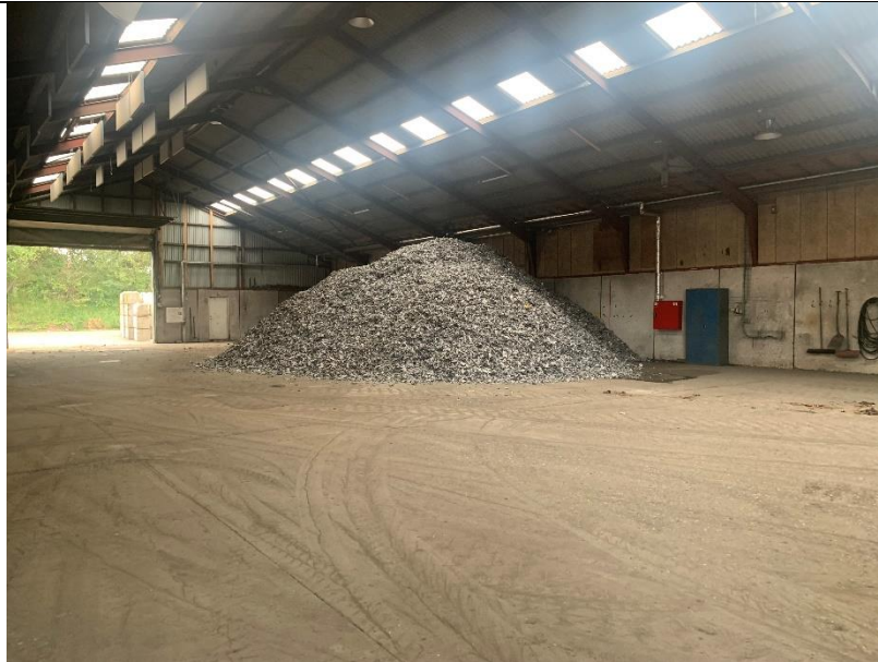
Tidligere hal hvor X-ray-anlægget tidligere var placeret. Anlægget er fjernet, dog forefindes stadig mindre oplag af aluminium, som vil blive fjernet.
