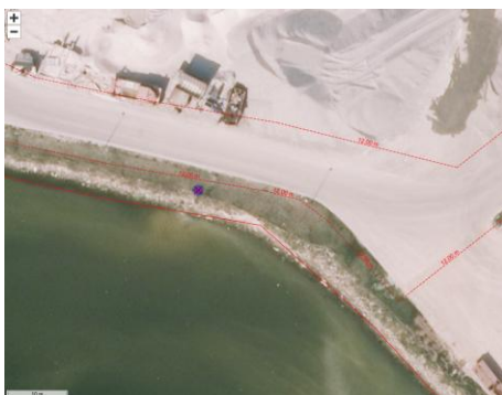
Figur 13e. Punktet markerer omtrentligt område, hvor det nedgravede rør føres gennem dæmningen på Etape 1. Forår 2018.
