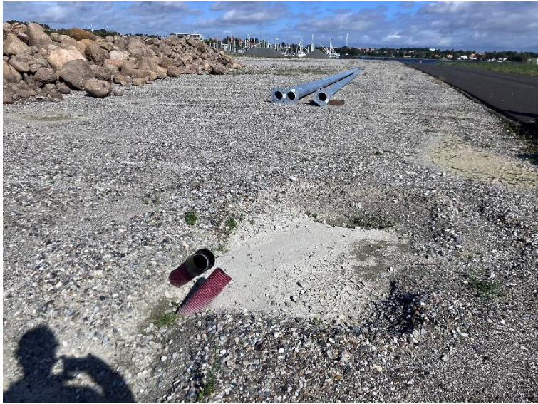
Figur 16. Bunke med sten etape 1. De galvaniserede rør er lysmaster, der planlægges rejst inden længe.
