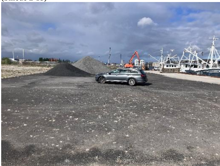
Figur 2 Mellemoplagsplads af asfalt ved kaj.
