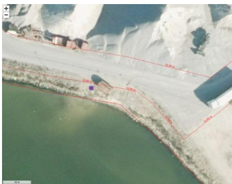
Figur 13c. Punktet markerer omtrentligt område, hvor det nedgravede rør føres gennem dæmningen på Etape 1. Sommer 2016.
