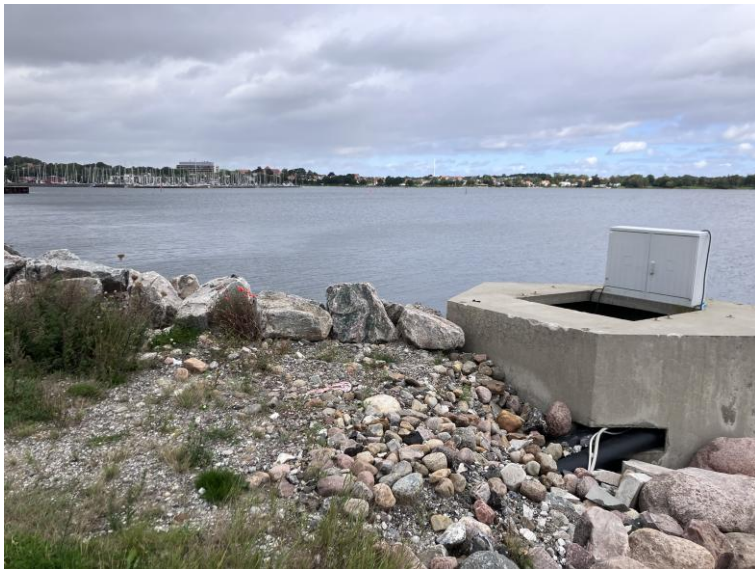
Figur 8 Prøvebrønd på nordlige side af etape 2.
