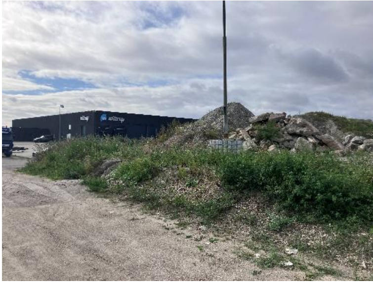
Figur 4 Oplag byggeaffald, ligger både på etape 1 og 2.
