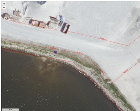
Figur 13d. Punktet markerer omtrentligt område, hvor det nedgravede rør føres gennem dæmningen på Etape 1. Forår 2017.
