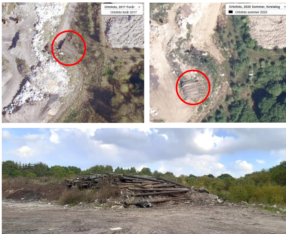
Figur 7. Telefonpæle på og ved etape 6. Øverst tv: Luftfotos fra foråret 2017 Øverst th: Luftfotos fra sommeren 2020. Nederst: Oplaget af telefonpæle på etape 6 som konstateret på tilsynet.
