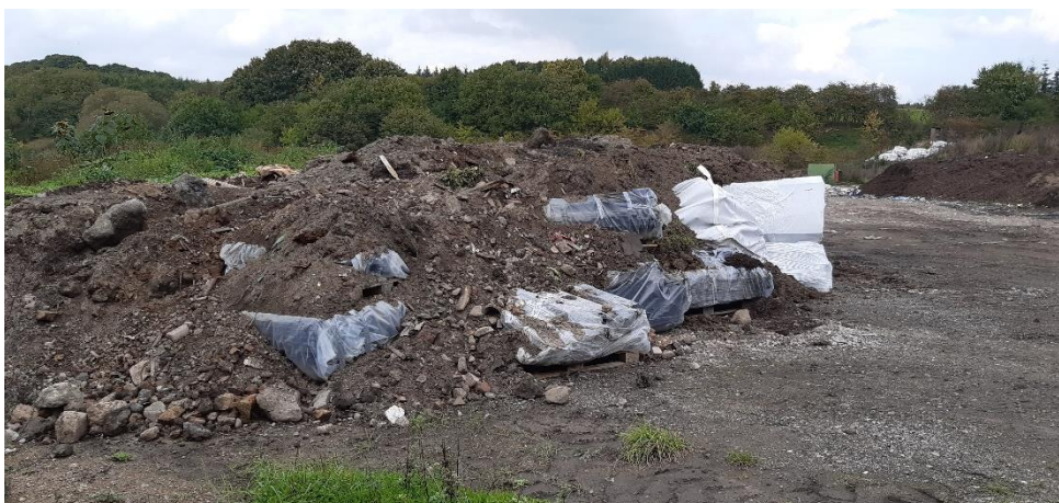
Figur 6. Delvist afdækkede asbestplader på etape 6.
