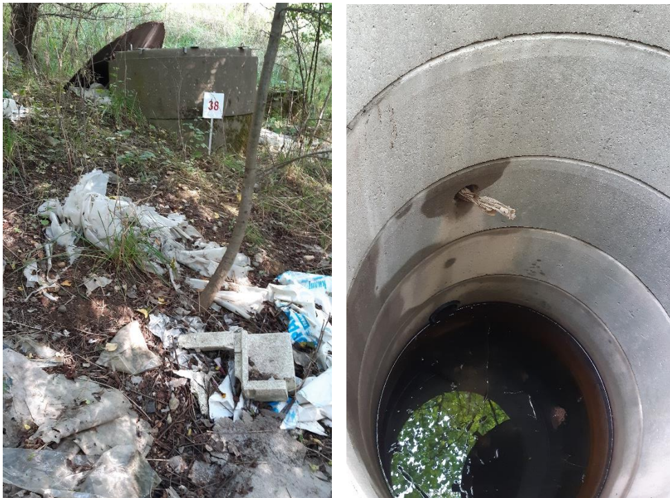
Figur 2: Affald omkring drænbrønde. Tv: Affald ved perkolat-brønd 38. Th: Papir i indløbet til drænbrønd 44.
