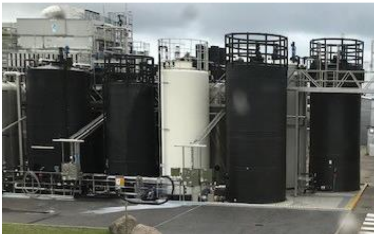
Figur 3. Spildbakke med plads til en tank til 27,7% natriumhydroxid ved siden af de 2 sorte tanke til højre i billedet.
