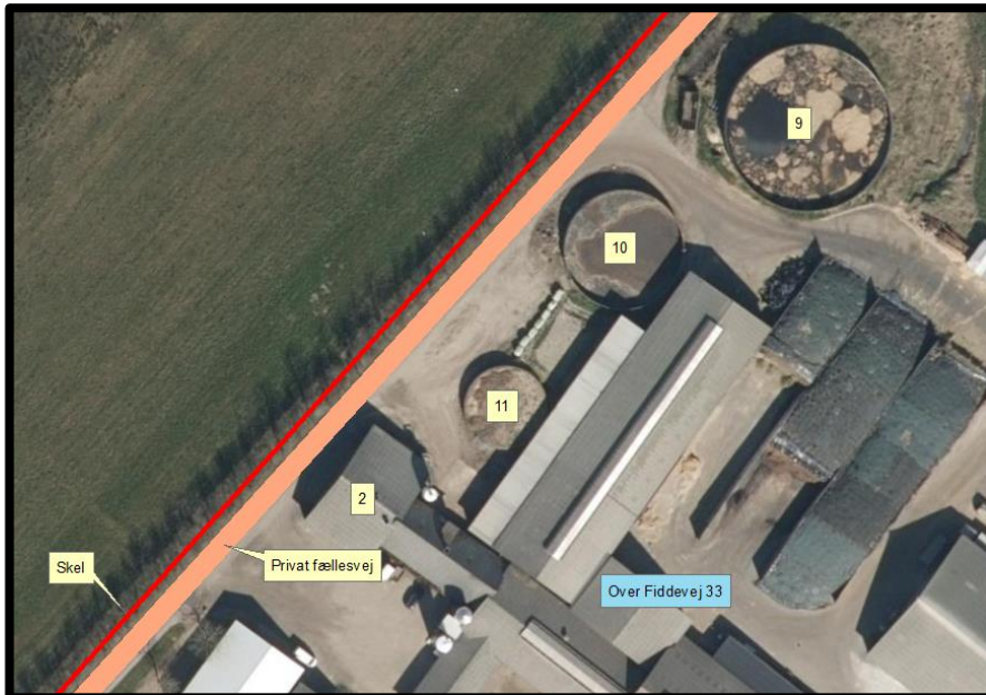
Figur 3. Manglende overholdelse af afstandskrav.
