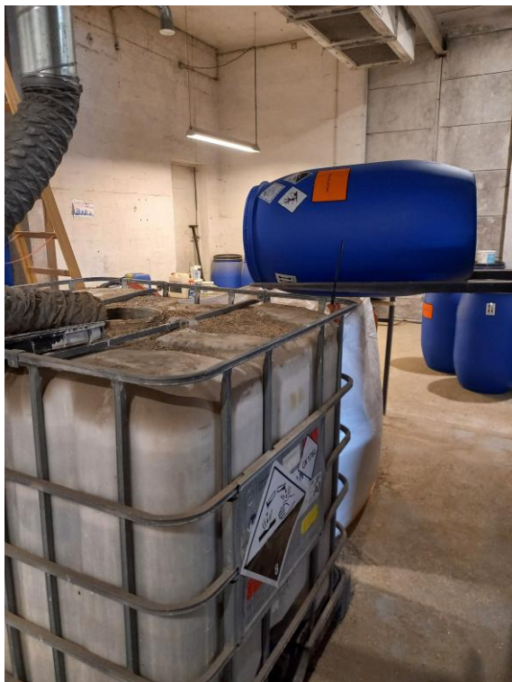
Syre eller base hældes om i 1000 liter palle tank, som står på tætbelægning med opsamling i grubbe.
