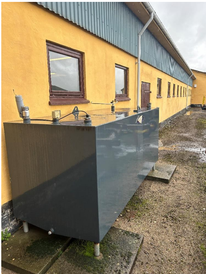
Fyringsolietank fra 2009
