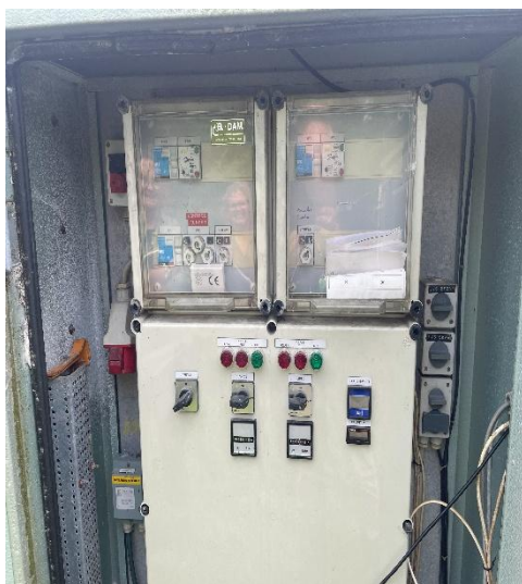
Foto 1: Eltavler for pumpe 1 og pumpe 2 Foto 2: Perkolatbrønd 1 -Der er perkolat i brønden
