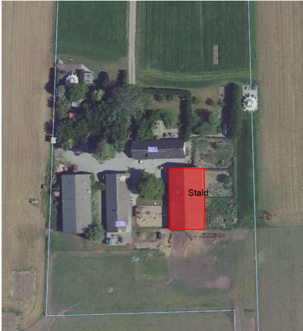
Figur 3.1.1 - Oversigtskort over eksisterende staldbygning til husdyrbrug der er søgt inddelt med flexgrupper, der er uændret bygningsareal, Løkkenvej 361, 9700 Brønderslev.
