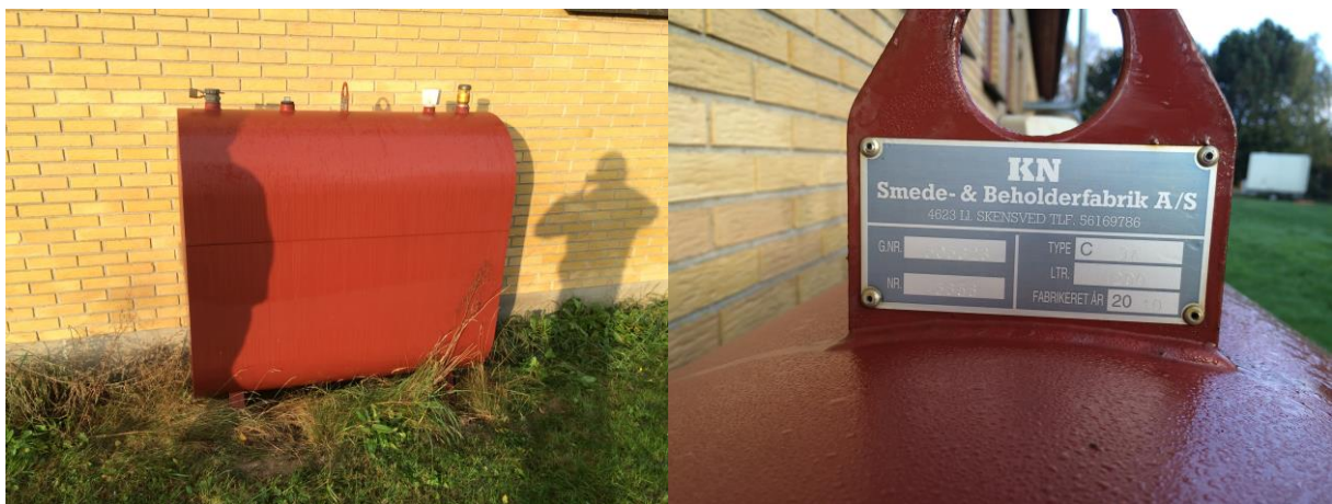
Overjordisk olietank til fyringsolie.
