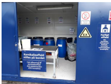
Billede 2. Opbevaringsrum til farligt affald
