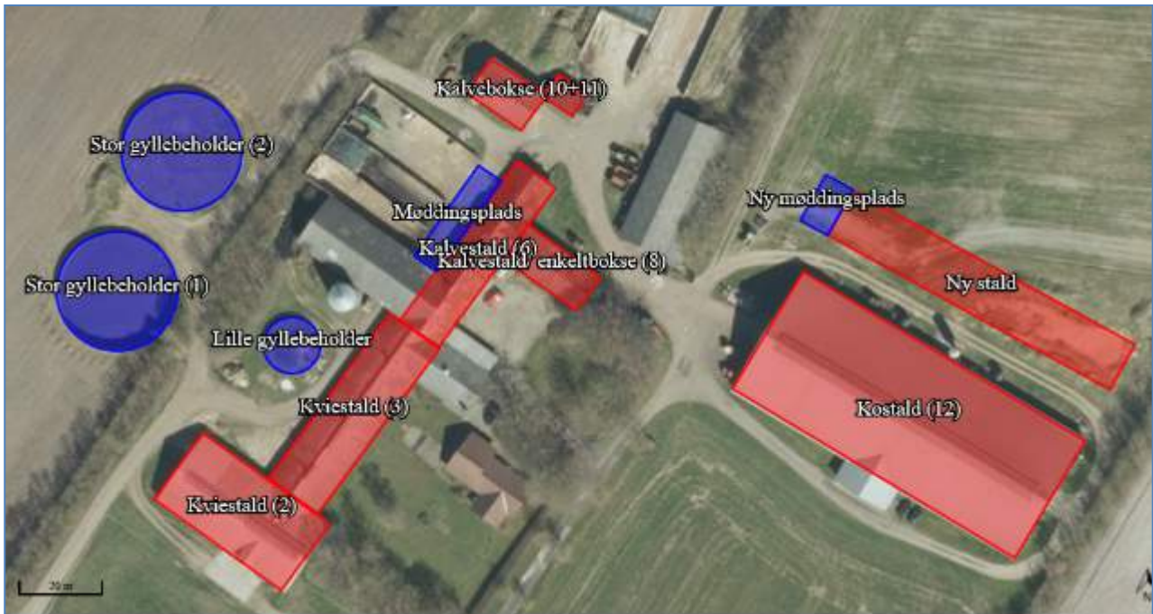
Figur 1: Husdyrbrugets stalde og opbevaringsanlæg. Foto: husdyrgodkendelse.dk
