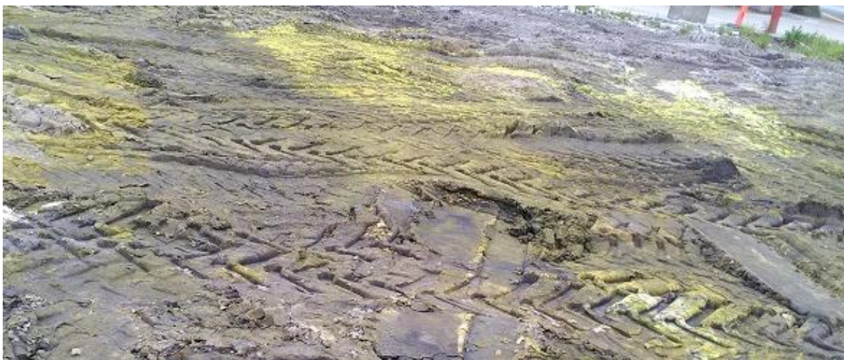
Den efterladte jord under tanke 2, 3 og 4 (1. juni 2021, 3 dage efter betondækket er fjernet)
