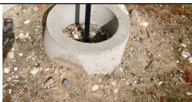
Tankgårdsventiler tilknyttet alle tankgårde.
