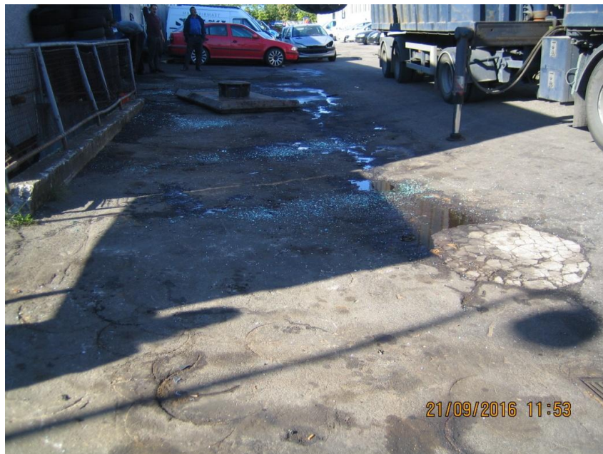
Foto 1: Glas og væsker ved siden af regnvandsbrønd.
