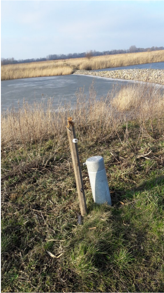
Figur. 9. Monitoringsbrønd i kanaldæmningen i etape Syd.
