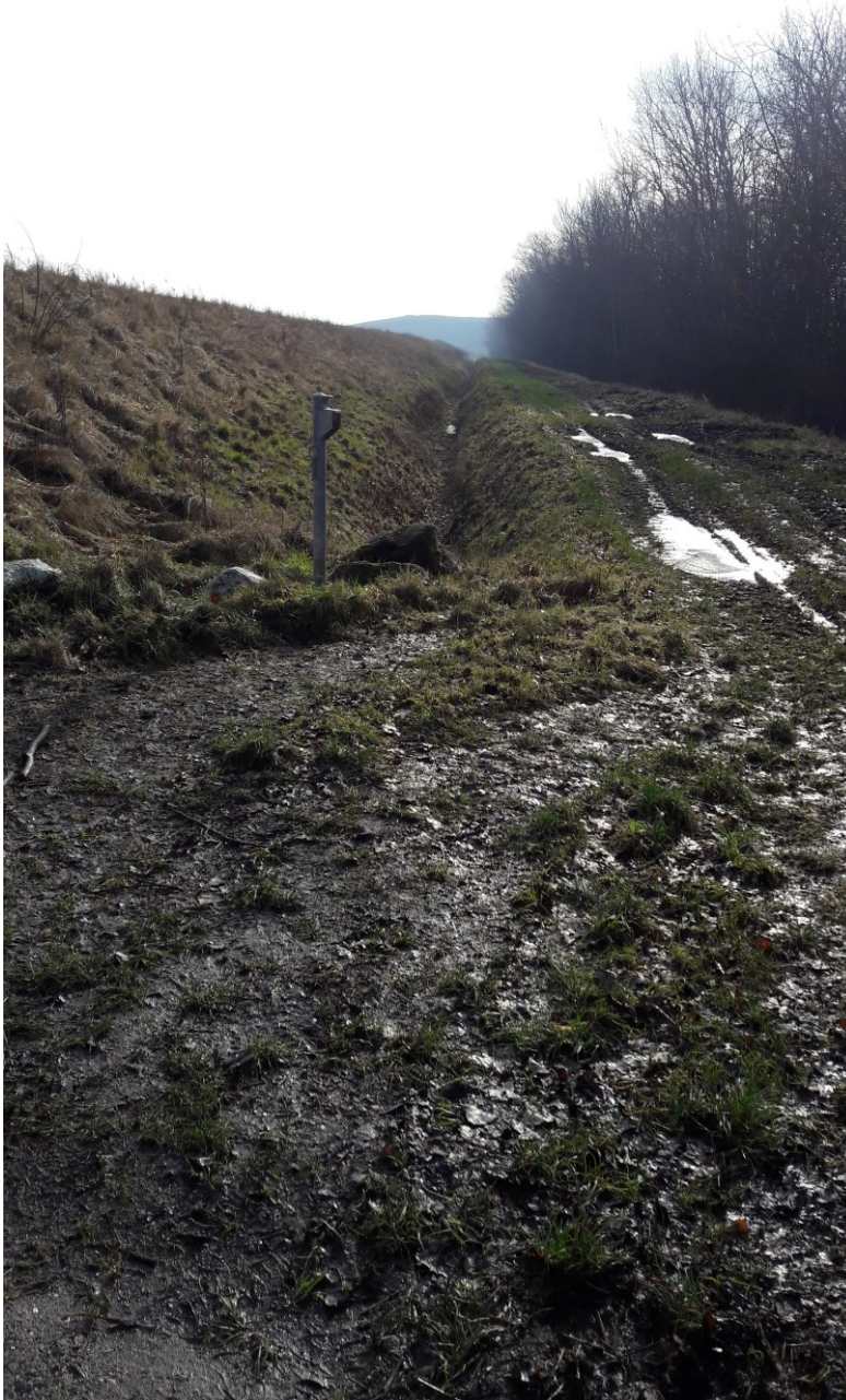
Figur. 7. Vestligt dige i spulefeltets Etape Syd. Omfangsgrøften er næsten tørlagt, hvilket indikerer at der ikke er udsivning af vand fra deponiet gennem dæmningerne/ digerne.
