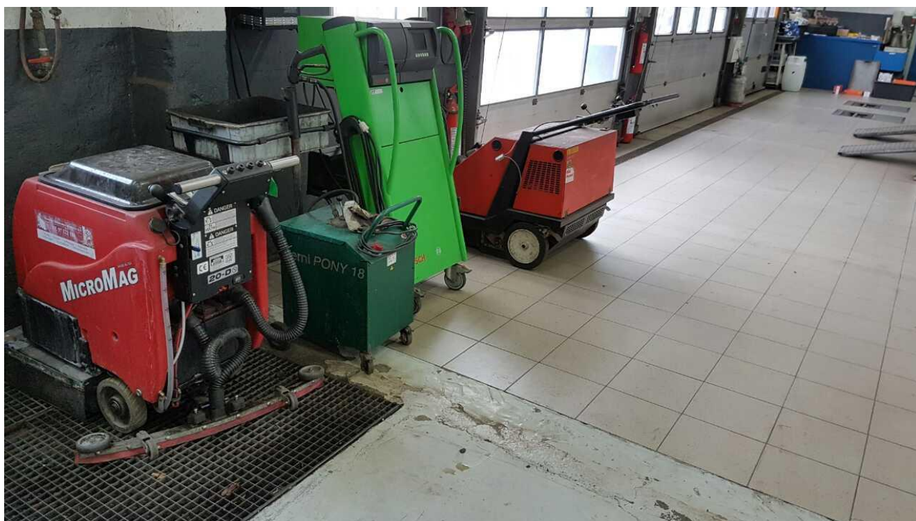
Afløbsrist for gulvvasker samt afløbsrende foran porte.
