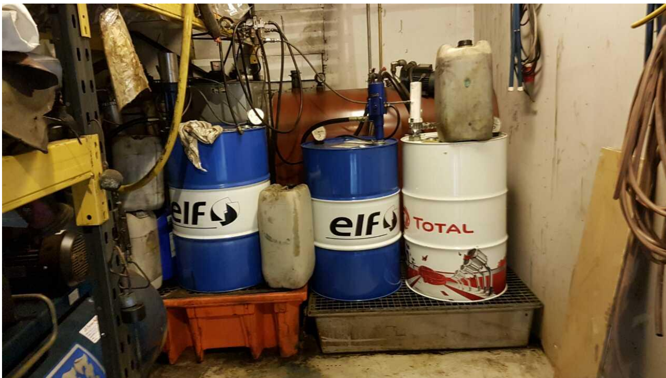
Opbevaring af råvarer og farligt affald på spildbakker i olierum.
