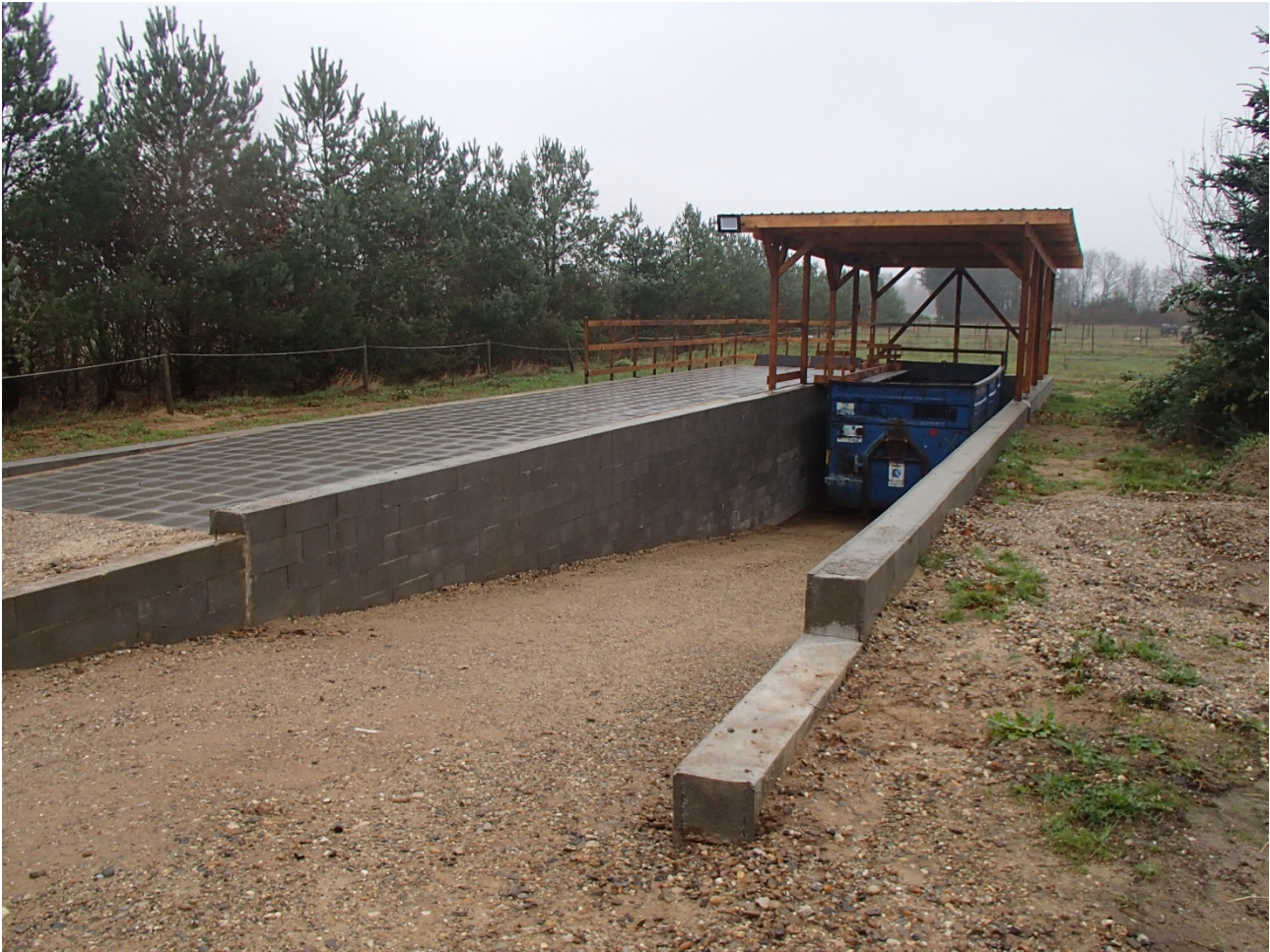
Figur 3. Plads til container og tilkørsel
