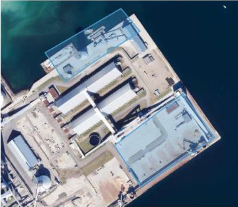
Figur 3: Oversigtsplan for de områder hvor aktiviteten vil foregå. Arbejdsområderne er markeret med blå skraveringer. Kilde: Danmarks Arealinformation, ortofoto.
