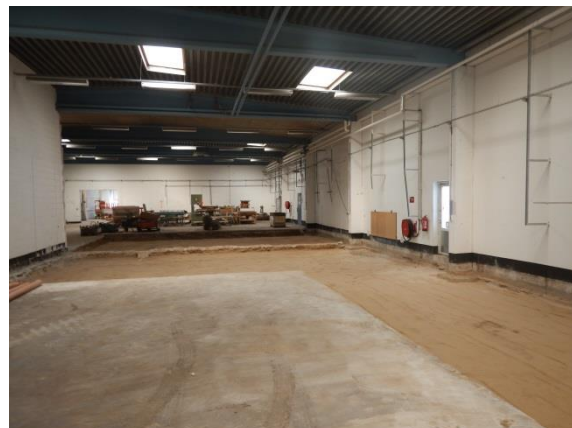
4. Indenfor. Anlægsarbejde i gang.
