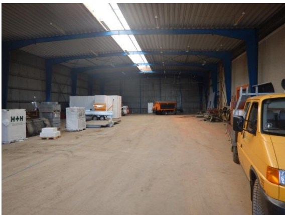
3. Indenfor. Anlægsarbejde i gang.
