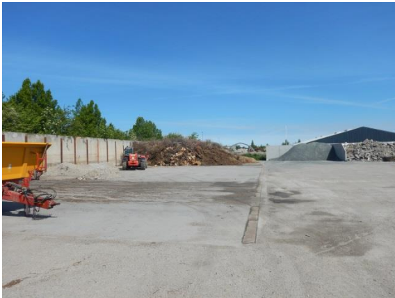
1. Grenplads med afløb til olieudskiller.
