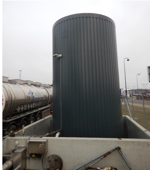
6. 40 m 3 tank, hvor den centrifugerede olie samt den øverste olieholdige del fra den anden 40 m 3 tank pumpes ind.
