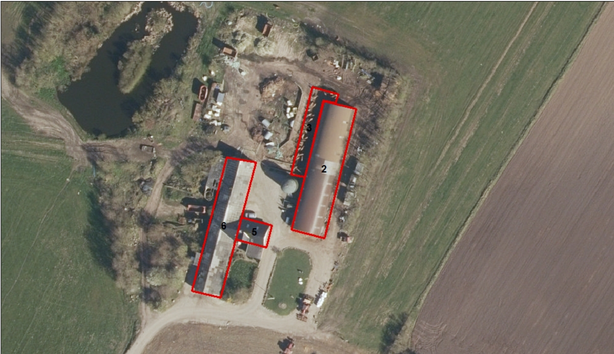
Figur 1b. Husdyrbrugets driftsbygninger ved ejendommen.
