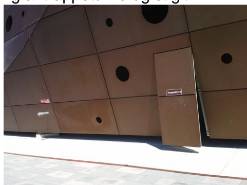
Trappetårn 3 og stigrør 3
