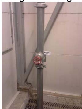
Stigrør i trappetårn 1
