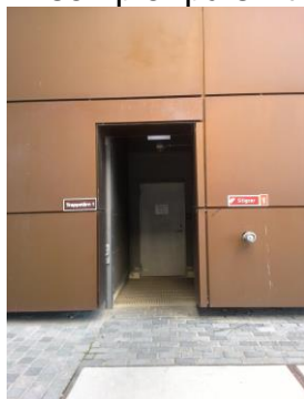
Trappetårn 1 og stigrør 1
