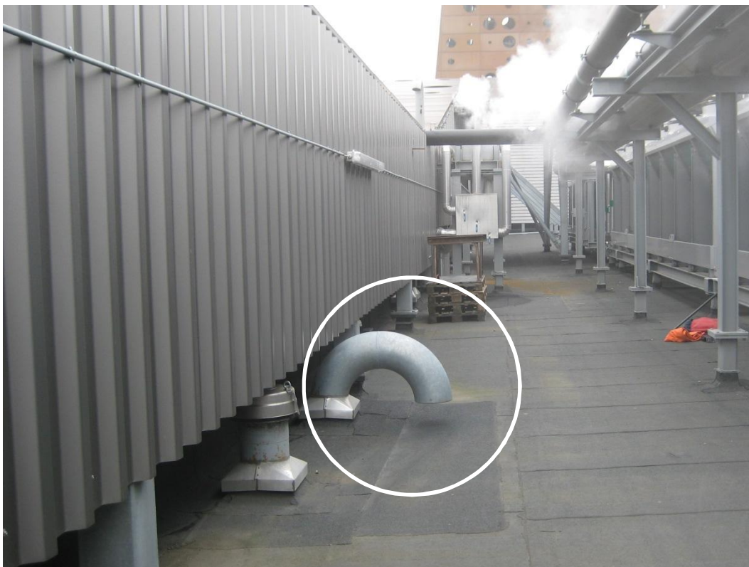
Foto 4, Udluftning på flyveaskesilo
