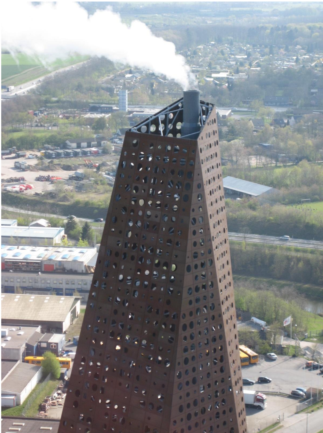
Foto 7, Skorsten (top af 98 m røgrør i ca. kote 147,50)
