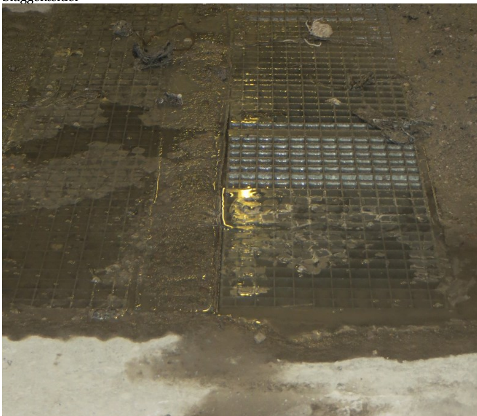
Riste til opsamling af slaggekølevand i slaggekælder Samlet vurdering
