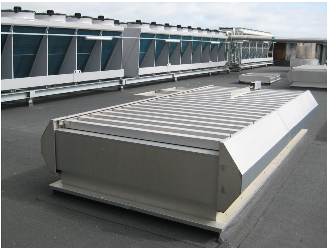
Foto 1, Colt røgoplukke (fjernvarmekølere og komponentkøler i baggrunden)
