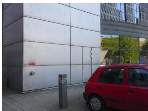
Trappetårn 5 og stigrør 5
