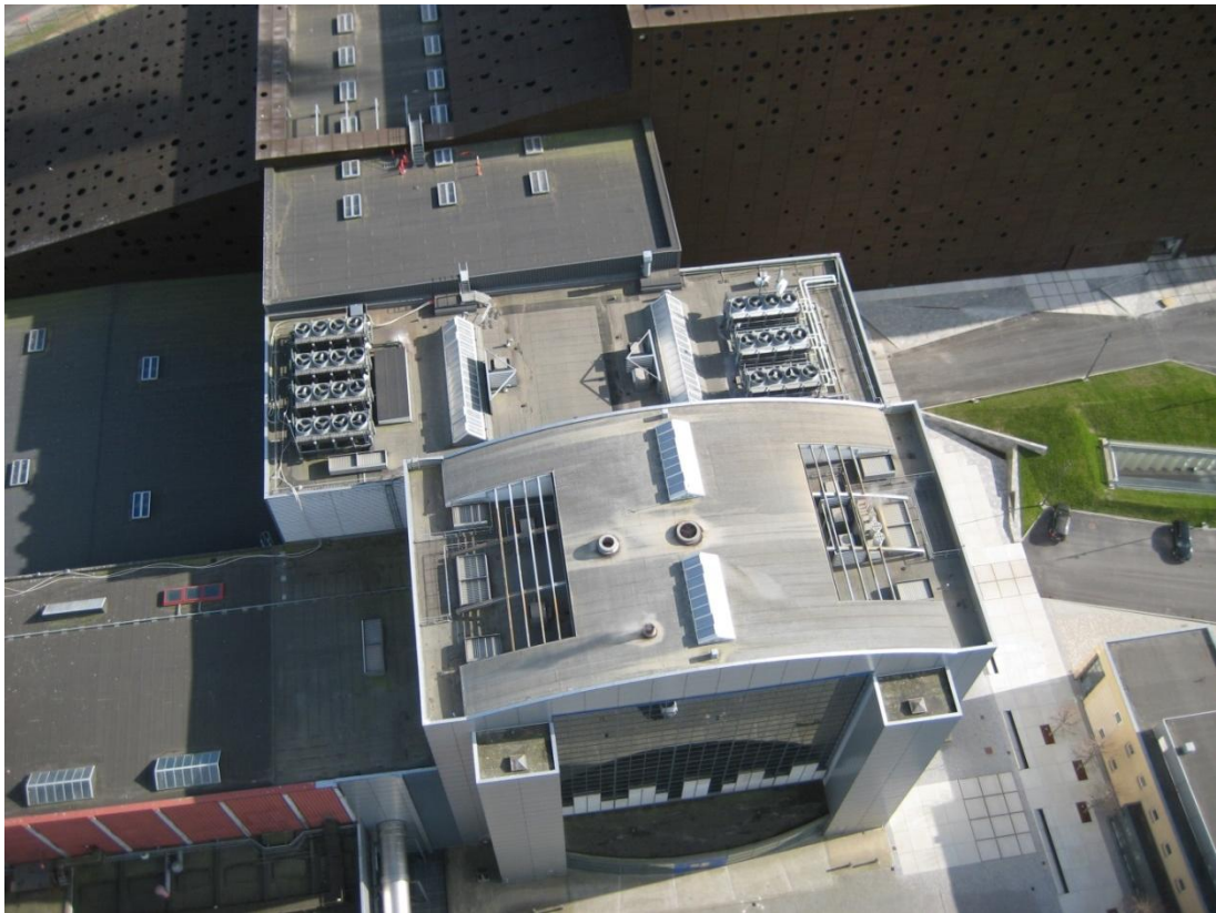
Foto 1; Bygninger til ovnlinie 5 set fra skorsten til ovnlinie 5 (ovnlinie 6 anes øverst i billedet)
