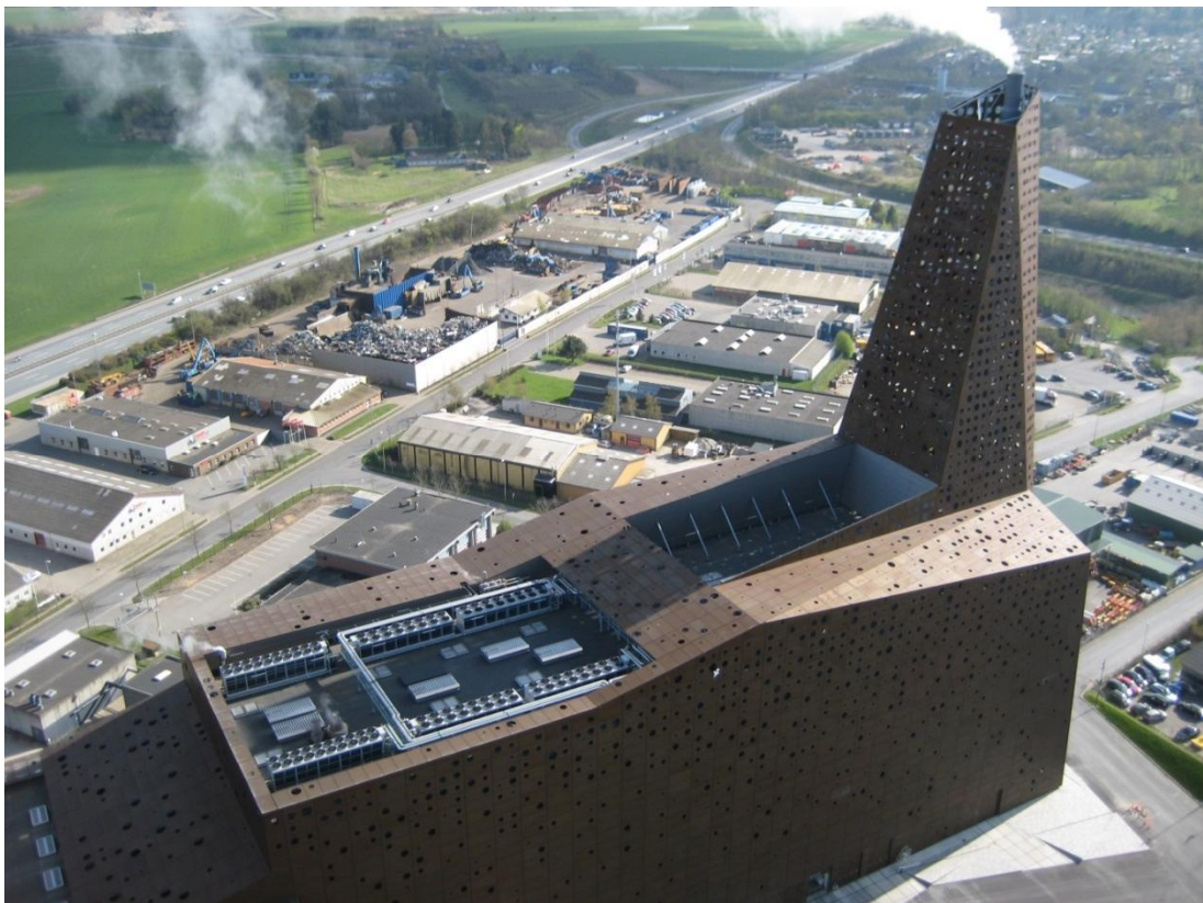
Foto 2; Bygninger til ovnlinie 6 set fra skorsten til ovnlinie 5
