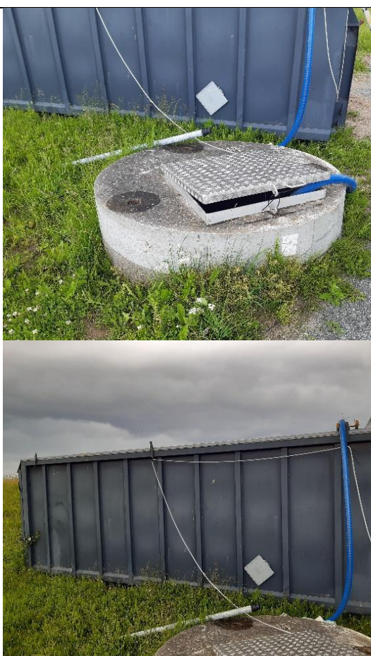
Figur 4. Containeren til midlertidig opsamling af perkolat fra etape 5.
