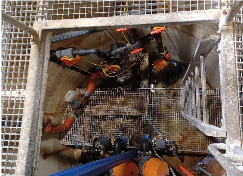
Figur 7. Adskillelse mellem perkolat fra etape 6.1 og overfladevand fra etape 6.2 med en væg mellem kamrene
