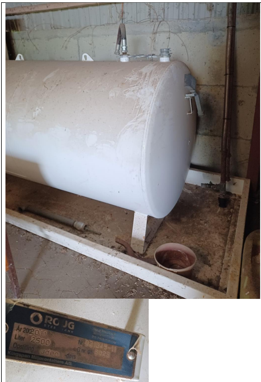
Figur 2. Gammel 2.500 liter olie tank placeret på spildbakke
