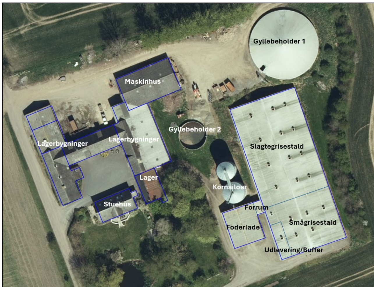
Figur 5. Anlægget på Dalegård
