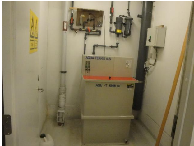
3 tryksandfiltre (Ø2350 mm) til filtrering af bassin vandet. Chlor-elektrolyse anlægget.
