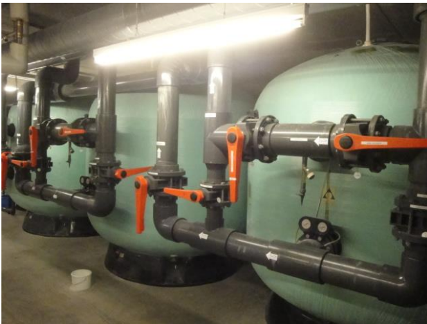
3 tryksandfiltre (Ø2350 mm) til filtrering af bassin vandet. Chlor-elektrolyse anlægget.
