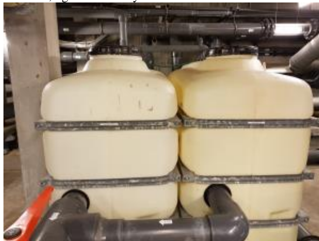
Udligningstanke.
