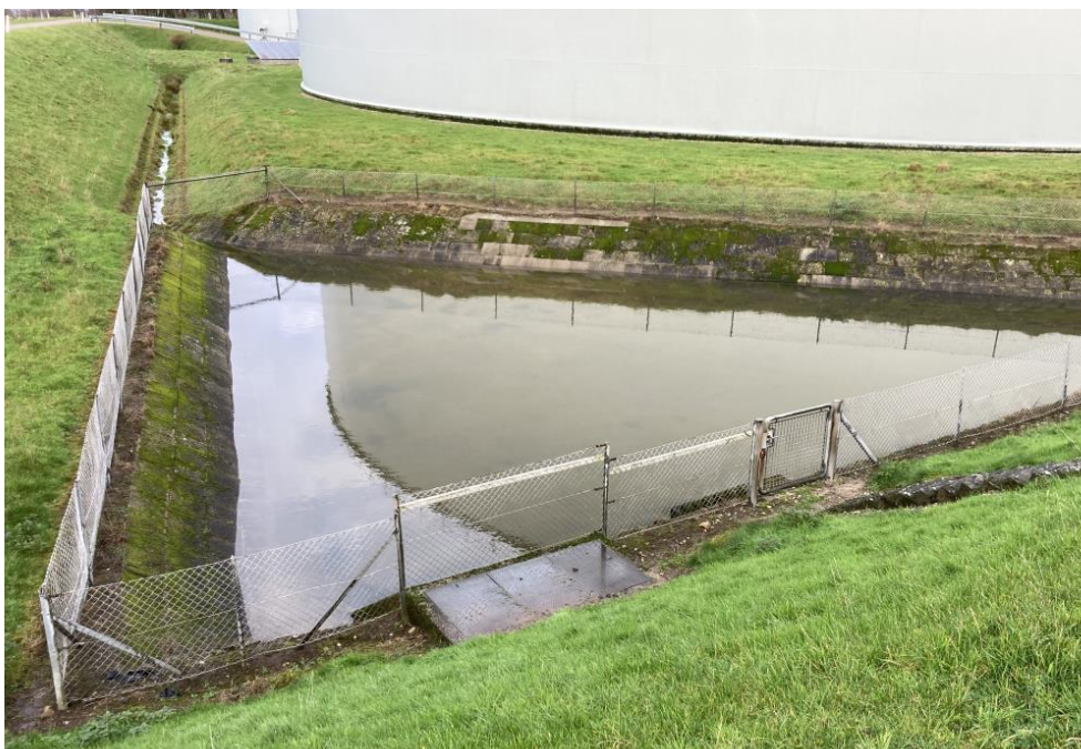
Figur 2. Et af FDO's trekantsbassiner til opsamling af overfladevand fra tankgårde
