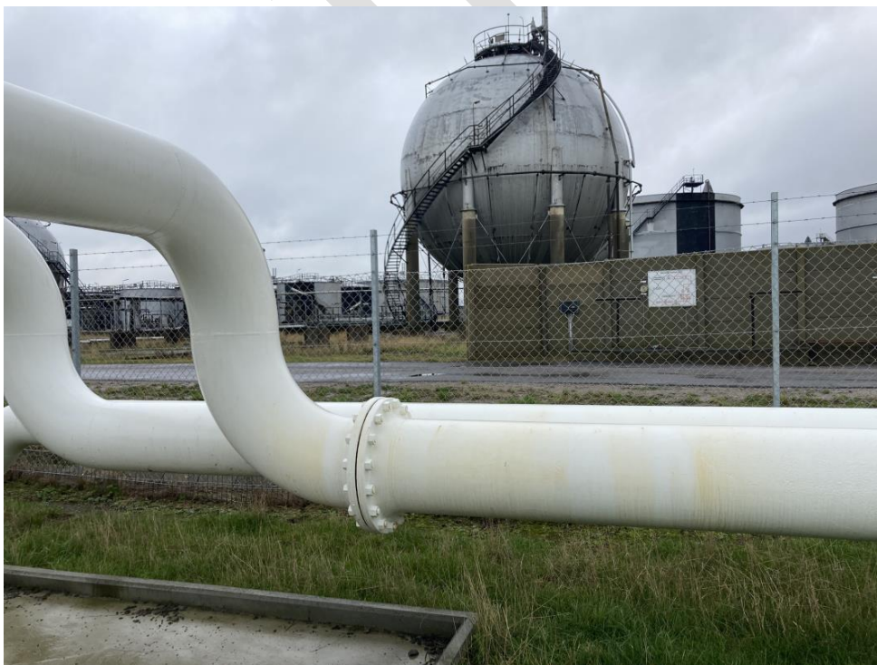
Figur 5. Området reetableret med betonbefæstelse og opkant som forebyggende foranstaltninger
