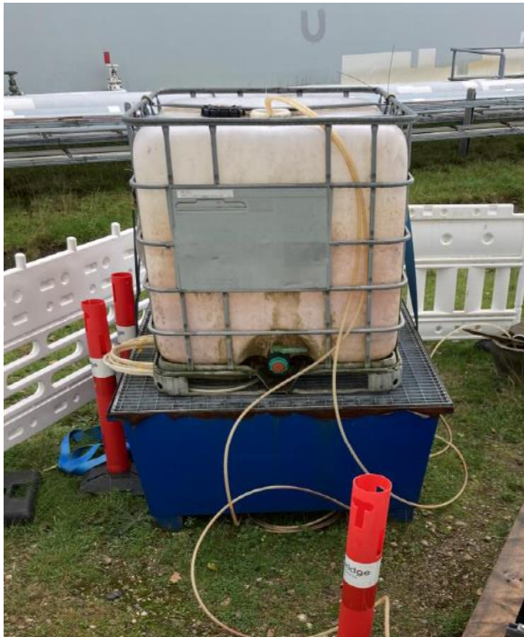
Figur 6. Oppumpning af fri fase grundvandsforurening ved tank T-8801/T8807
