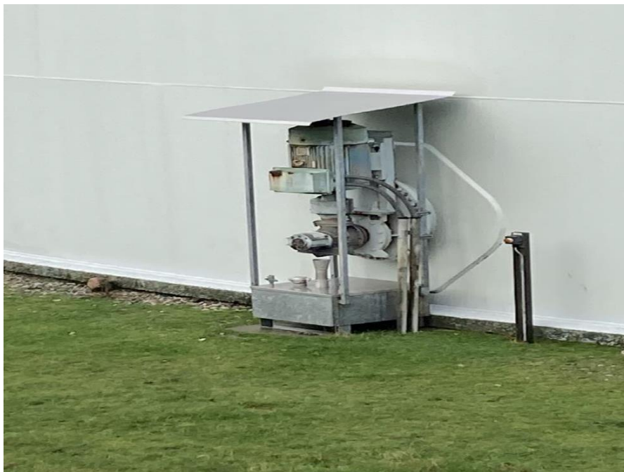
Figur 4. Overdækket tankmixer med spildbakke
