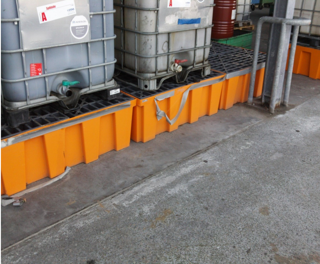
BILAG 2: Pallettanke med spildolie placeret over opsamlingskar af hård plast
