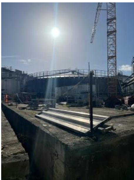
Bygning af Tank 4
