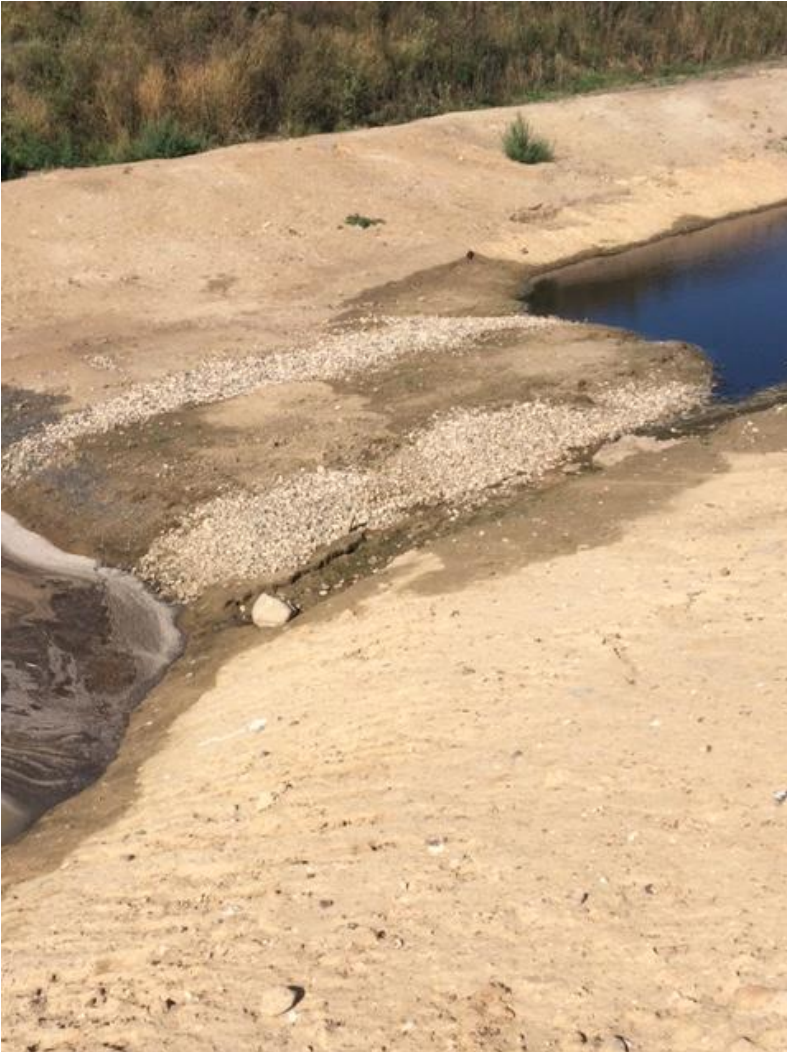
Gennembrud mellem de to bassiner i lagunen.
