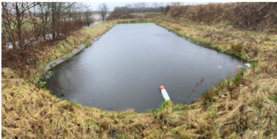
Figur 2 - Foto af bassin 3
