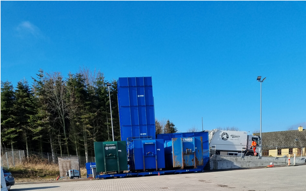
3 komprimatorcontainere med henholdsvis madaffald, restaffald og papaffald.
