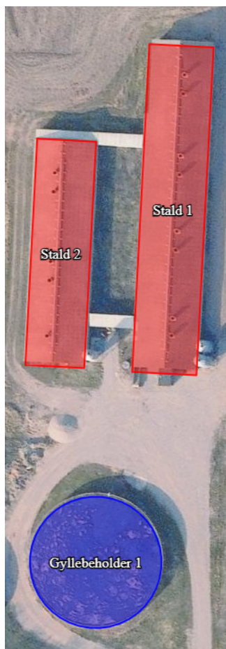
Figur 1. Oversigt over stalde og gødningsopbevaringsanlæg.
