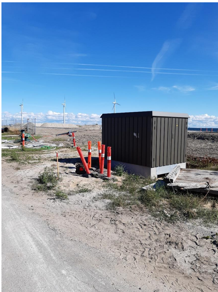
Billede 2.: Manglende hegn langs deponiets vestlige side.
