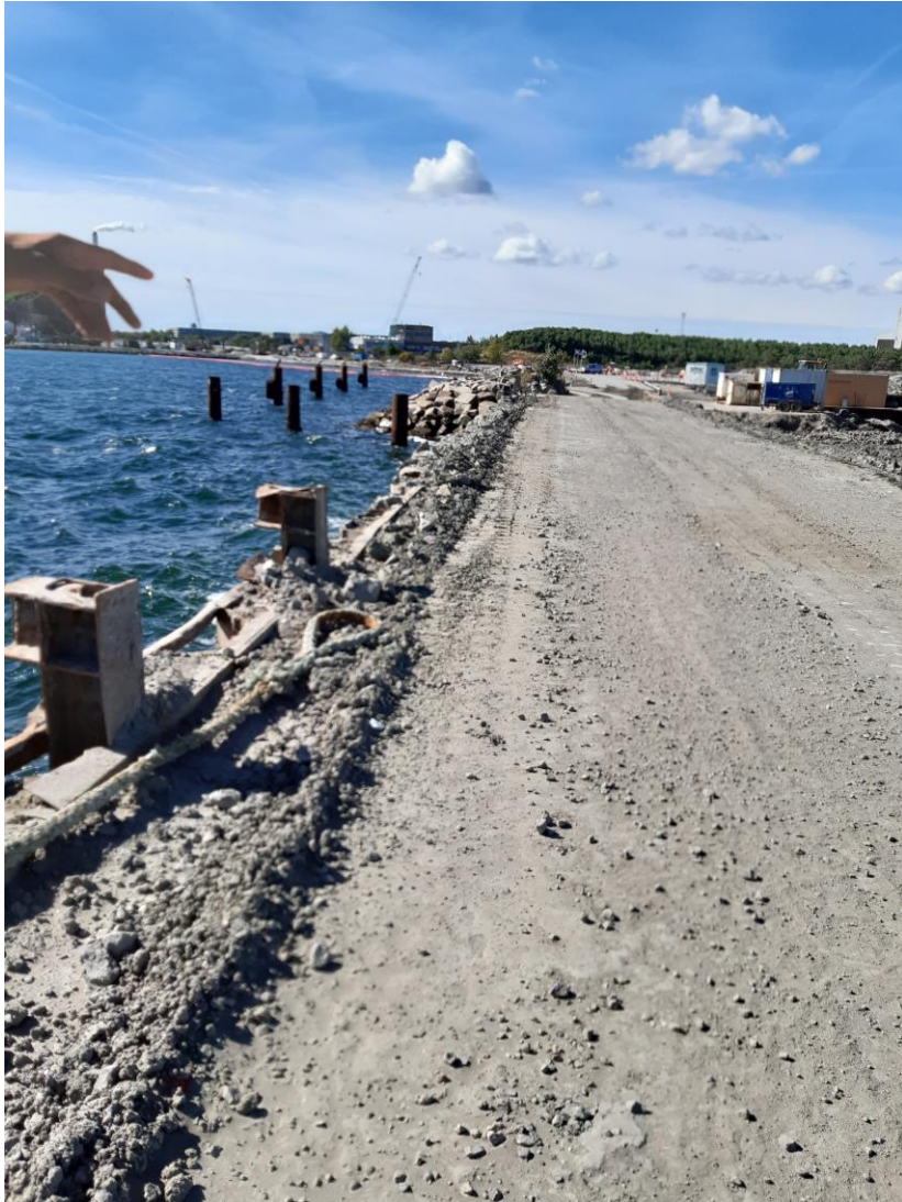
Billede 4.: Spild af mindre mængde havbundssediment langs aflæsningsrampens kant.
