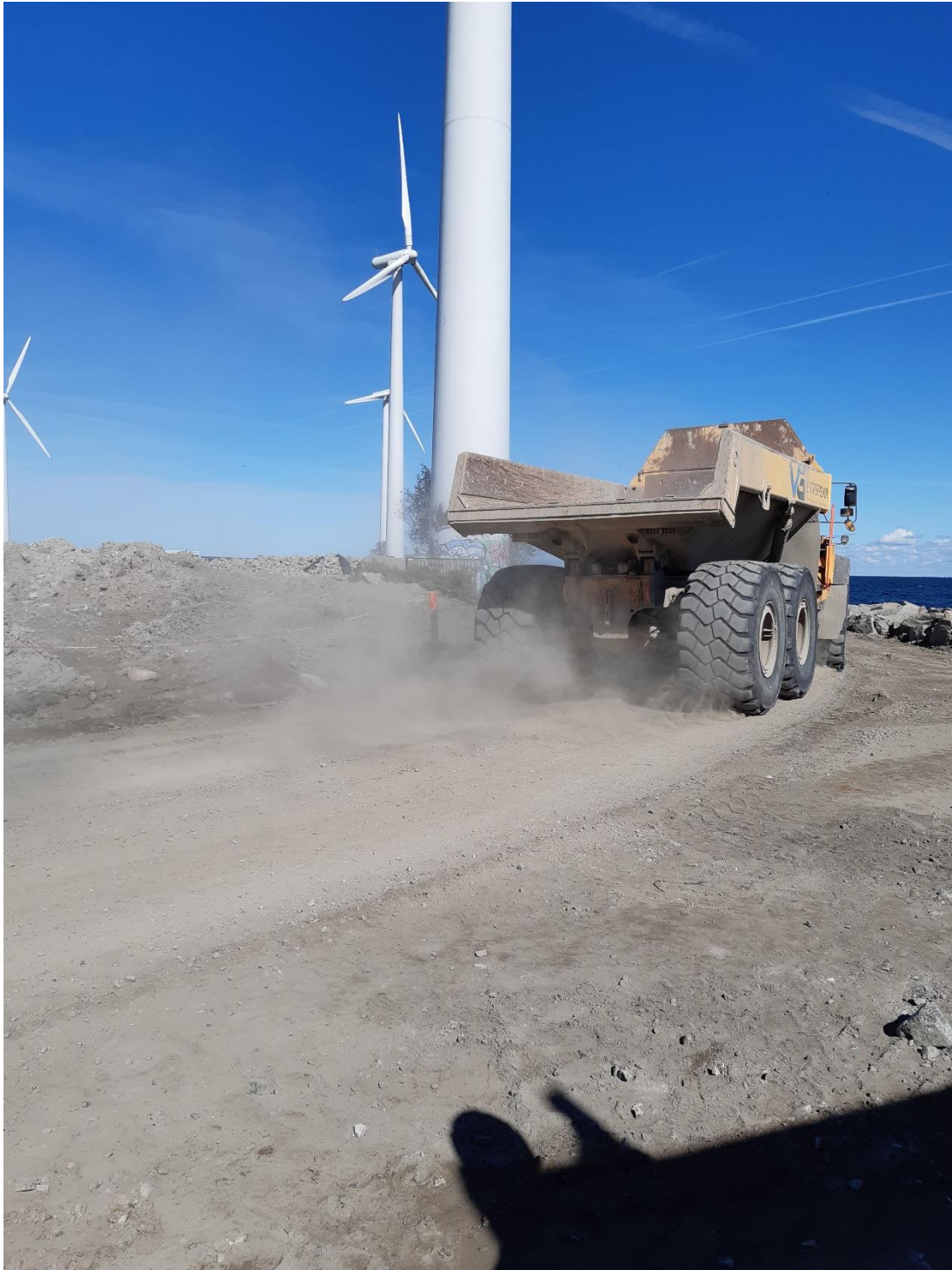
Billede 5.: Arbejdsførsel langs Havbundssedimentsdepotets dæmning.
