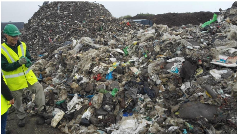
Foto 9. Restfraktion efter gensortering af grovere affaldsfraktioner, bestående hovedsageligt af marksten, mindre sten og brokker, som er blandet med en mindre del af bl.a. plast og tekstil.
