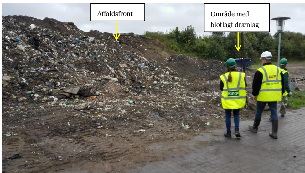
Foto 1. Etape 1 set fra sydvest. Fotoet viser affaldsfront efter afgravning af affald fra etappen, samt området hvor grovsortering af afgravet affald er foregået.
