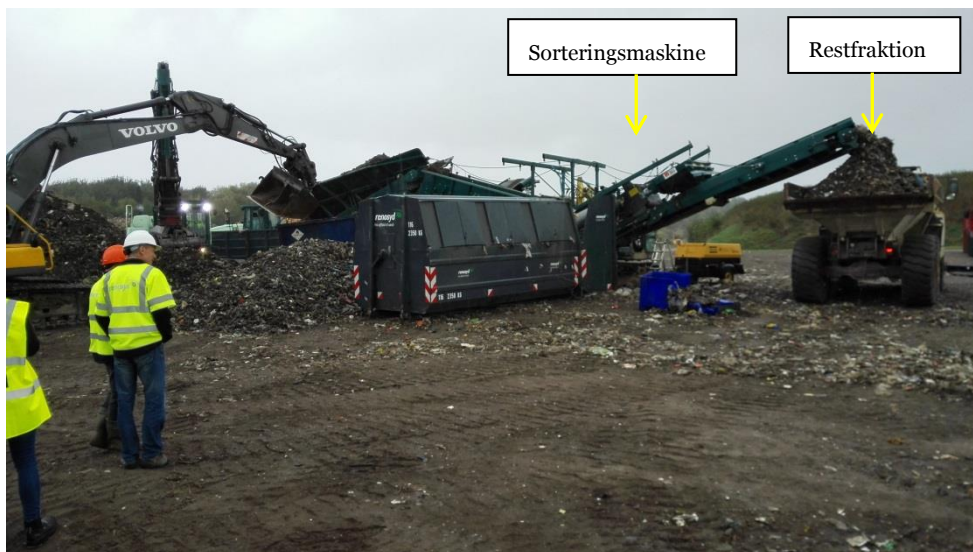
Foto 3. Sorteringsmaskine etableret på Etape 2. Fotoet viser en gensortering af en mellemfraktion til 4 fraktioner bestående primært af hhv. jord, metaller, plast og restfraktion. Restfraktionen lastes direkte på dumper og køres til midlertidig oplagring på Etape 2.
