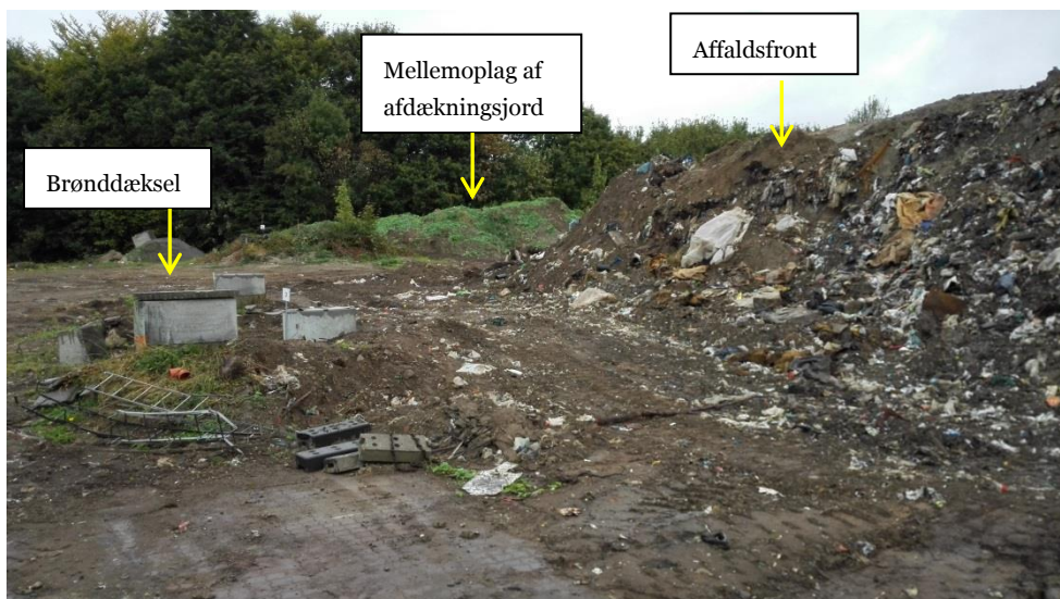
Foto 2. Etape 1 set fra sydvest. Fotoet viser affaldsfront efter afgravning af affald fra etappen samt mellemoplæg af afrømmet afdækningsjord til genanvendelse ved slutetablering af Etapen. Desuden ses nyligt genetablerede brønddæksler og brøndringe ved perkolatbrønde på etappen.
