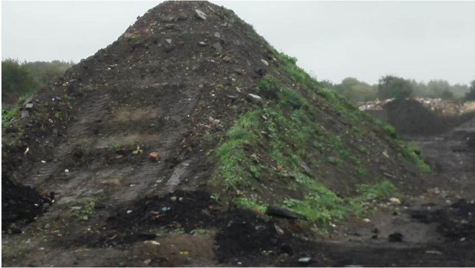
Foto 13. Midlertidigt oplag af aførømmet afdækningslag fra Etape 1. Jorden er tiltænkt anvendelse ved slutafdækning af etapen.
