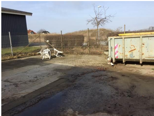
Afløb fra container til olieudskiller
