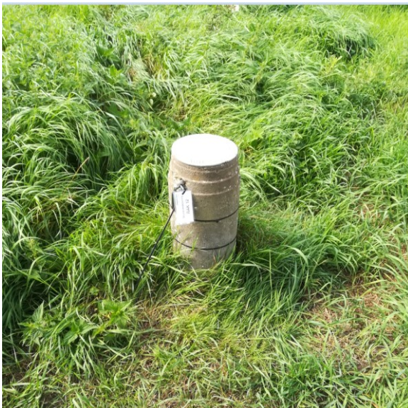
Moniteringsboring RAK12 udvendig, nedstrøms. Boringen er aflåst, har hætte og er mærket med nr. Boringen er ikke forsynet med DGU nr. (130.967?)
