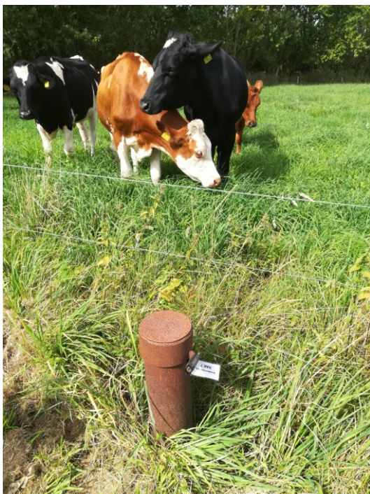
Moniteringsboring RAK7 NV for deponiet, opstrøms. Boringen er aflåst, har hætte og er mærket med nr. Boringen er ikke forsynet med DGU nr. (130.962?)
