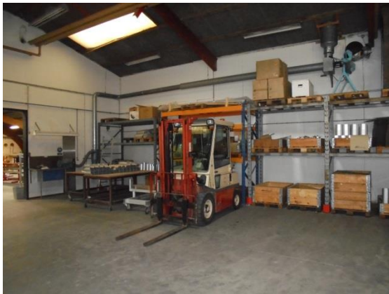
Maskine, hvorfra der sker udsugning til afkast A
