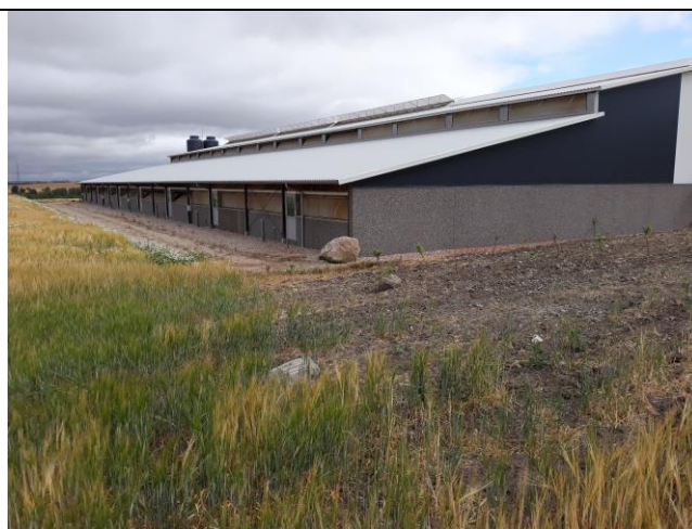
Foto 2. 3-rækket hegn etableret syd for staldbygning.
