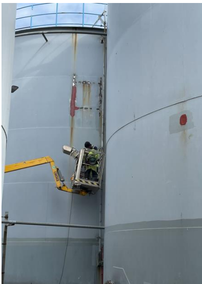
Renovering af tank 4
