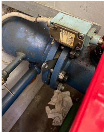
Ventil afmonteret ved bunkeranlæg vest på Oliekajen samt spade i flangesamling på tilhørende ledning i pumpehus.
