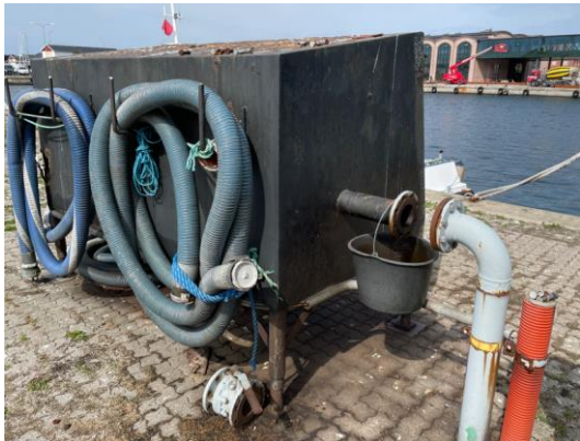
Ventil afmonteret ved bunkeranlæg vest på Oliekajen samt spade i flangesamling på tilhørende ledning i pumpehus.
