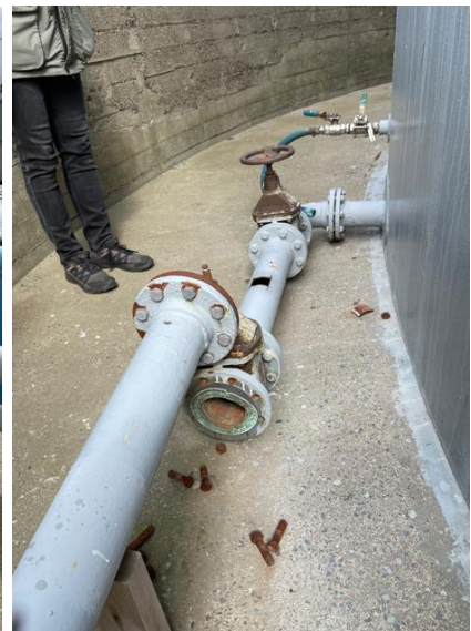
Tank 2, afmonteret ventil
