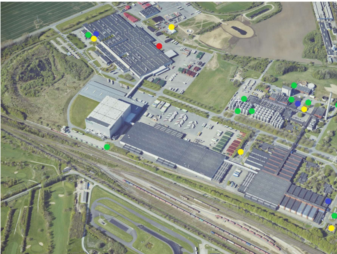
Figur 2. Oversigtskort set fra syd. Udendørs oplagssteder til affald er markeret med gul. Større værksteder er markeret med blå, rød er vaskeplads, mens udendørs oplag og påfyldningspladser er vist med grøn.
