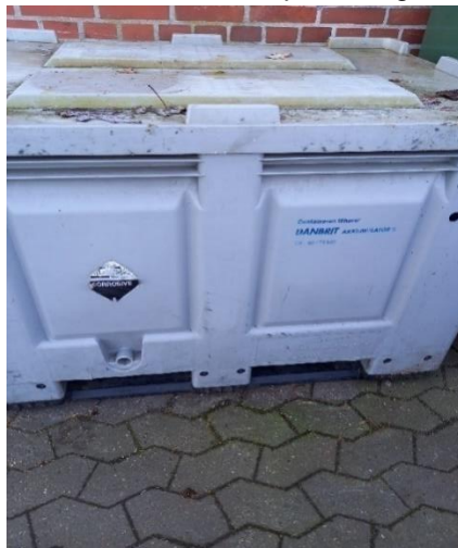
Billede 6: Udendørs opbevaring af batterier i syrefast container med låg fra Danbrit
