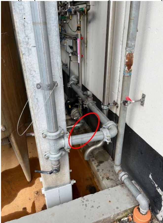
Dyse til udblæsning af skum i tankgrav ved F4.
