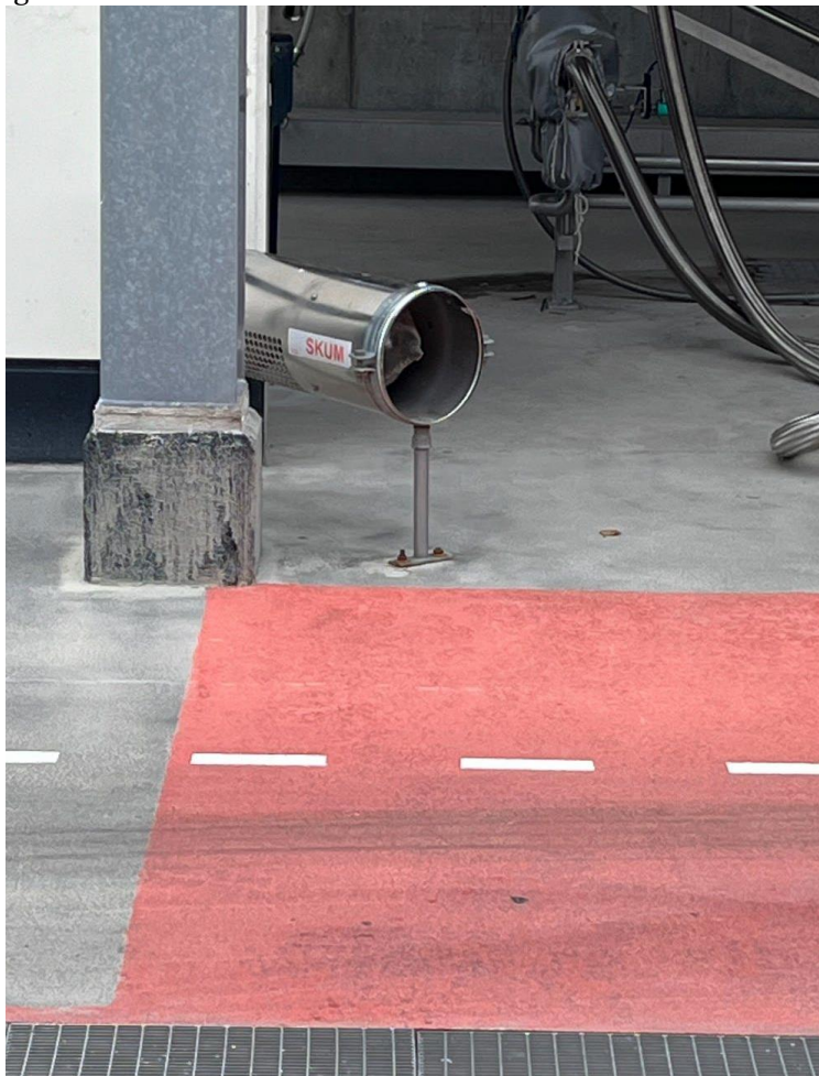
Dyse til udblæsning af skum på læsse-/tankvognspladsen
