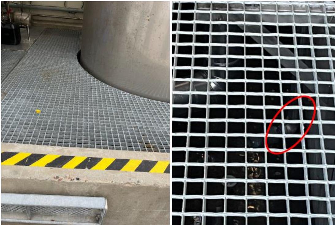
Rist over tankgrav og dyse til udblæsning af skum i tankgrav ved F3
